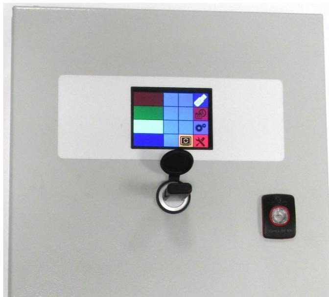
Coffret de régulation sur la page d'enregistrement des données sur clé USB avant traitement sur Xcell.
