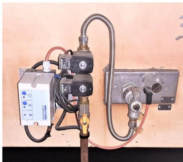
Panoplie gaz d'alimentation simple allure avec contrôleur de flamme
